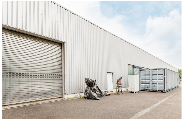
Hallenseitenansicht mit Rolltor
