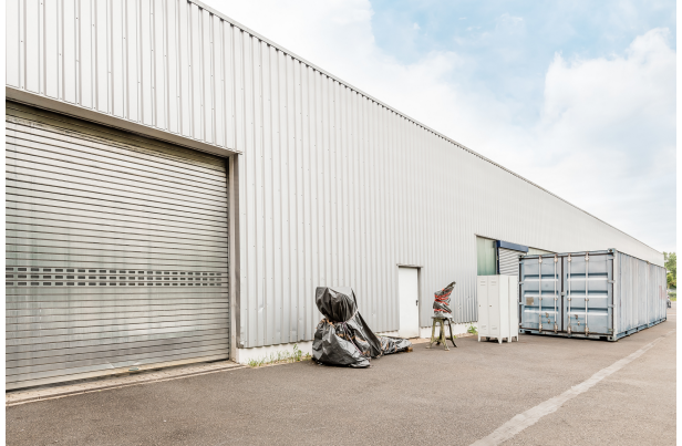
Hallenseitenansicht mit Rolltor
